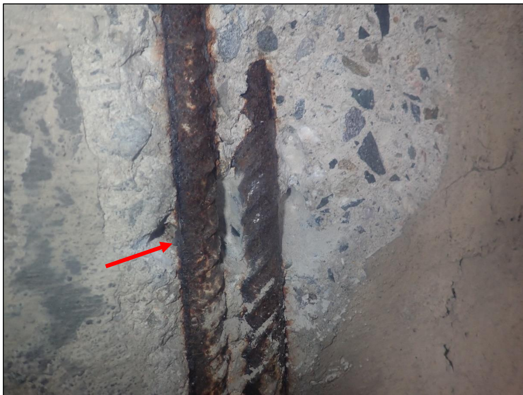
Foto 17: Detail sondy S9, svislá výztuž pilíř. Žebírková výztuž, průměr 25 mm, plošná koroze, krytí výztuže cca 0-10 mm
