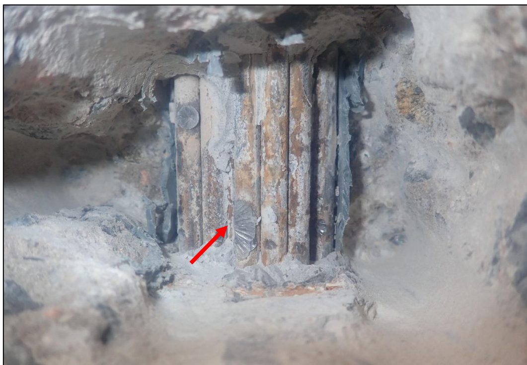
Foto 3: Detail sondy P3, předpínací výztuž NK, poloha viz Tabulka 3. Na předpínací výztuži byla nalezena povrchová koroze. Kanálek zcela vyplněn injektážní směsí. Krytí předpínací výztuže cca 67 mm.
