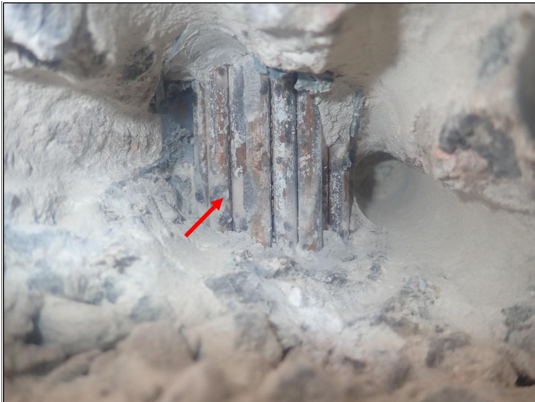
Foto 4: Detail sondy P4, předpínací výztuž NK, poloha viz Tabulka 3. Na předpínací výztuži nebyla nalezena koroze. Kanálek zcela vyplněn injektážní směsí. Krytí předpínací výztuže cca 80 mm.
