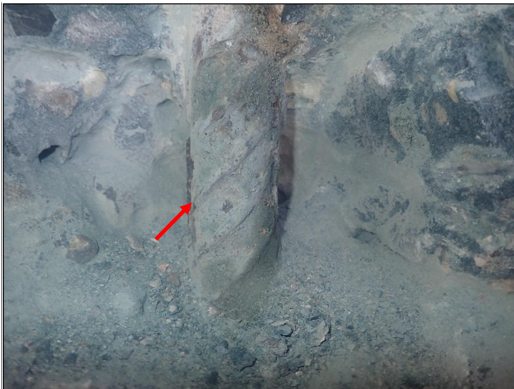
Foto 11: Detail sondy S3, svislá výztuž pilíře. Žebírková výztuž, průměr 32 mm, bez koroze, krytí výztuže cca 65 mm
