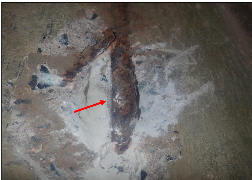
Foto 15: Detail sondy S7, svislá výztuž stativo. Žebírková výztuž, průměr 26 mm, povrchová koroze, krytí výztuže cca 15 mm
