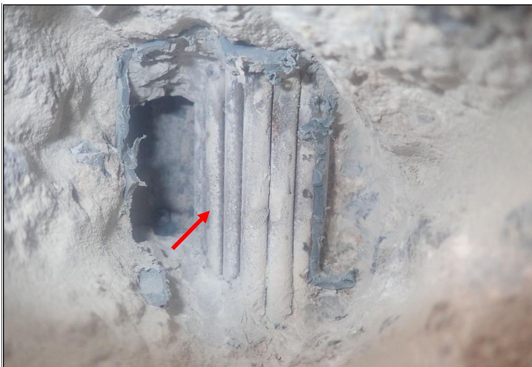
Foto 6: Detail sondy P6, předpínací výztuž NK, poloha viz Tabulka 3. Na předpínací výztuži nebyla nalezena koroze. Kanálek z 85% vyplněn injektážní směsí. Krytí předpínací výztuže cca 70 mm.
