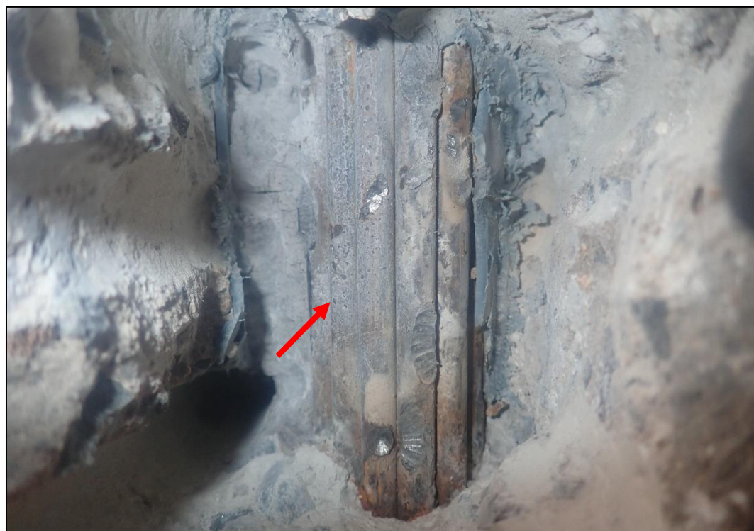
Foto 1: Detail sondy P1, předpínací výztuž NK, poloha viz Tabulka 3. Na předpínací výztuži nebyla nalezena koroze. Kanálek zcela vyplněn injektážní směsí. Krytí předpínací výztuže cca 50 mm.
