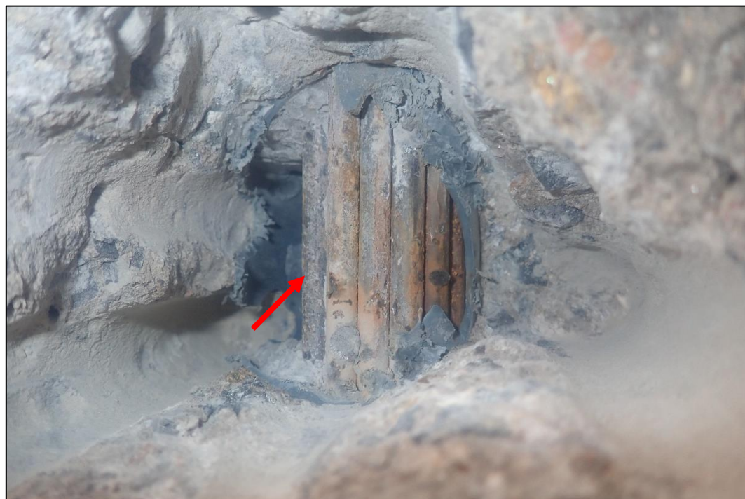
Foto 2: Detail sondy P2, předpínací výztuž NK, poloha viz Tabulka 3. Na předpínací výztuži byla nalezena povrchová koroze. Kanálek z 80% vyplněn injektážní směsí. Krytí předpínací výztuže cca 65 mm.
