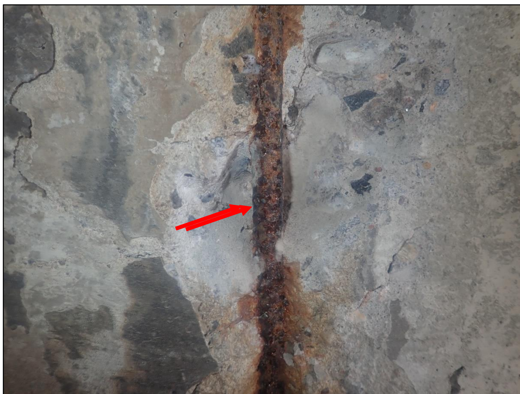
Foto 16: Detail sondy S8, svislá výztuž pilíř. Žebírková výztuž, průměr 14 mm, plošná koroze, krytí výztuže cca 20 mm
