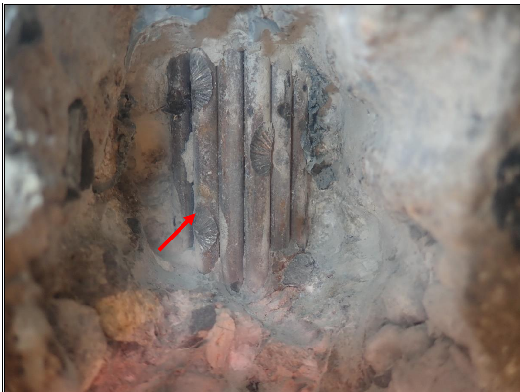
Foto 8: Detail sondy P8, předpínací výztuž NK, poloha viz Tabulka 3. Na předpínací výztuži nebyla nalezena koroze. Kanálek zcela vyplněn injektážní směsí. Krytí předpínací výztuže cca 63 mm.
