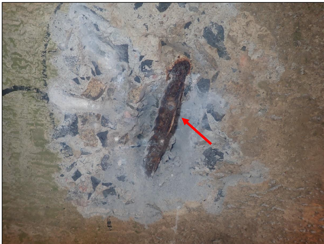
Foto 12: Detail sondy S4, svislá výztuž ÚP. Žebírková výztuž, průměr 12 mm, plošná koroze, krytí výztuže cca 15 mm
