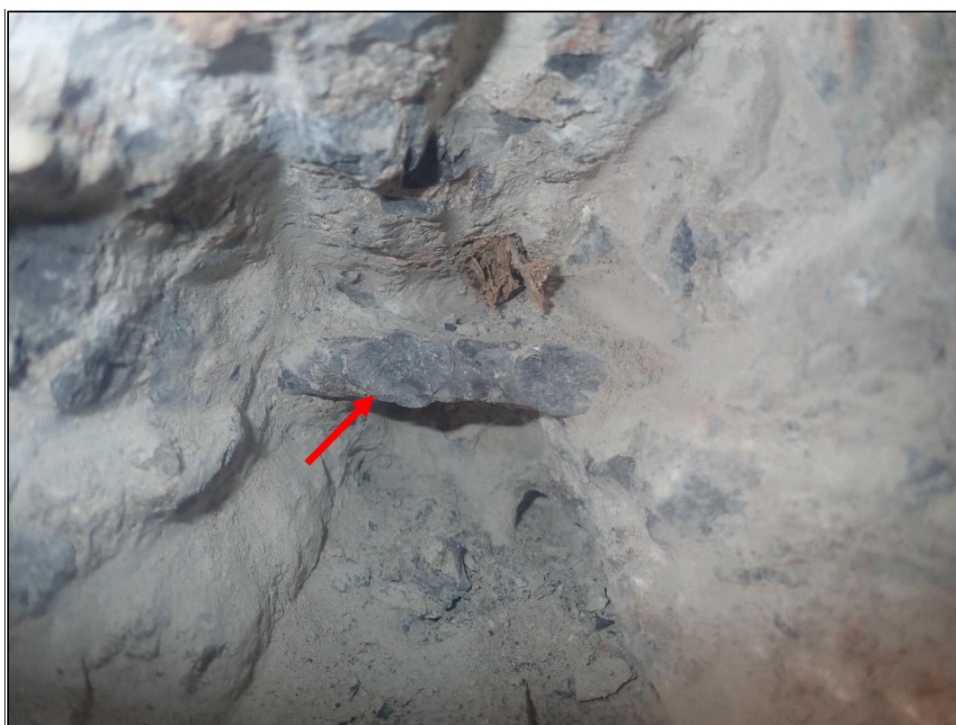
Foto 10: Detail sondy S2, vodorovná výztuž ÚP. Žebírková výztuž, průměr 12 mm, bez koroze, krytí výztuže cca 95 mm
