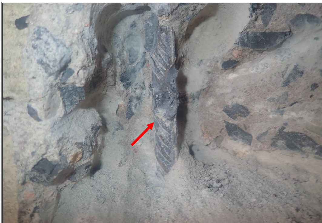
Foto 9: Detail sondy S1, svislá výztuž ÚP. Žebírková výztuž, průměr 12 mm, bez koroze, krytí výztuže cca 32 mm
