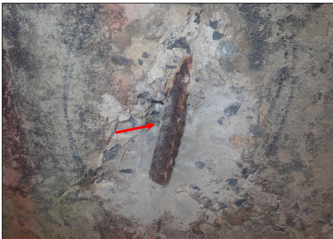
Foto 13: Detail sondy S5, svislá výztuž ÚP. Žebírková výztuž, průměr 12 mm, plošná koroze, krytí výztuže cca 15 mm
