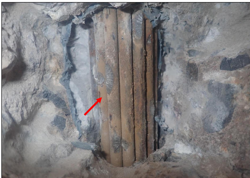
Foto 5: Detail sondy P5, předpínací výztuž NK, poloha viz Tabulka 3. Na předpínací výztuži byla nalezena povrchová koroze. Kanálek zcela vyplněn injektážní směsí. Krytí předpínací výztuže cca 60 mm.
